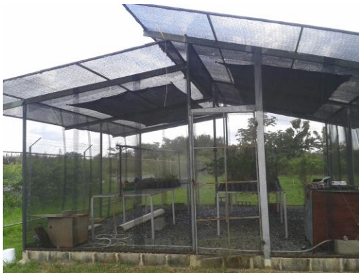
Fig.7. Instalaciones del Invernadero en el Centro Regional
