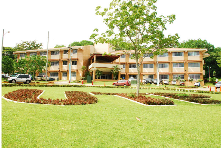
Figura 1: Edificio 2 vista frontal.
