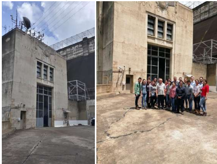
Figura 3. Instalaciones de la hidroeléctrica Madden (izquierda) y foto grupal de los participantes de la gira (derecha).
