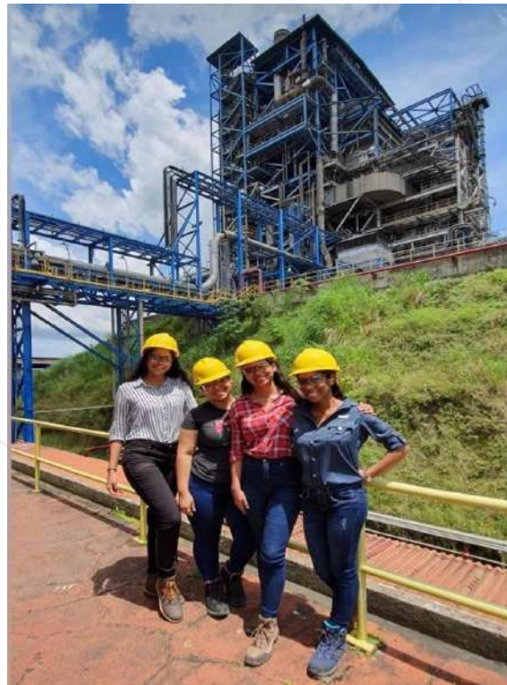
Figura 5. Jóvenes participantes de la gira frente a la caldera de la Termoeléctrica.
