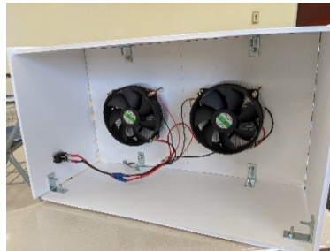
Figura 21. Conexión del nodo común al switch. Fuente: Propia.
