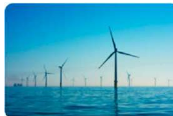
Energías renovables y eficiencia energética
