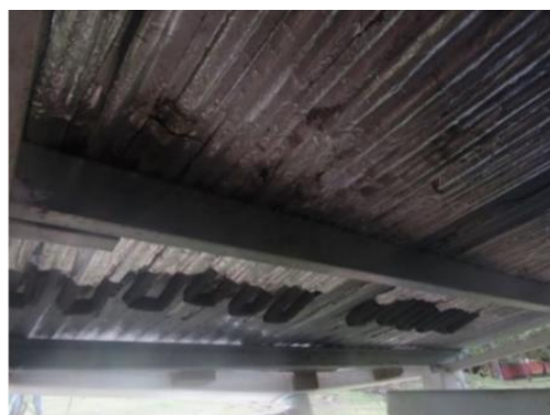
Fig. 10. Intercambiador de calor instalado.
