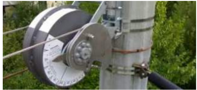
Figura 5. Equipo Tensorex. Ingeniería conceptual Línea 2. Especificaciones funcionales, técnicas y contractuales. Tomo II. Equipamientos [37].
