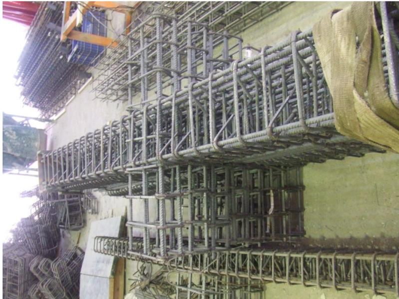
Figura 4.12. Disposición del armado utilizado en cada uno de los soportes
