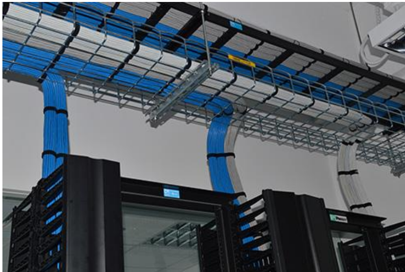
Figura 5.: Instalación de cableado estructurado
