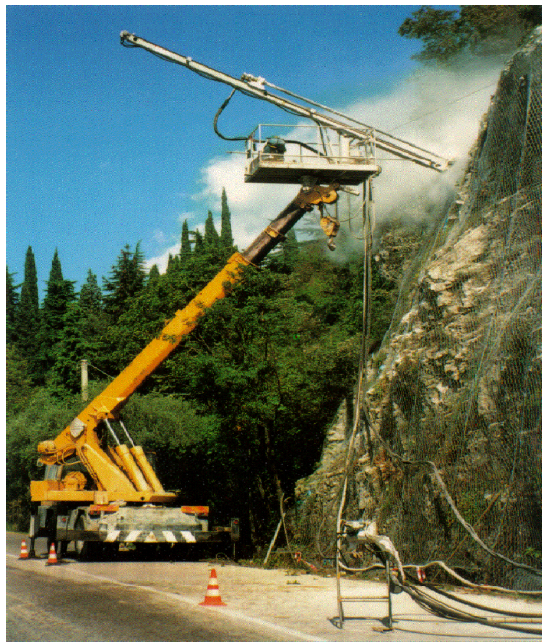
Figura 5.1 Labores de consolidación en laderas de montañas.
